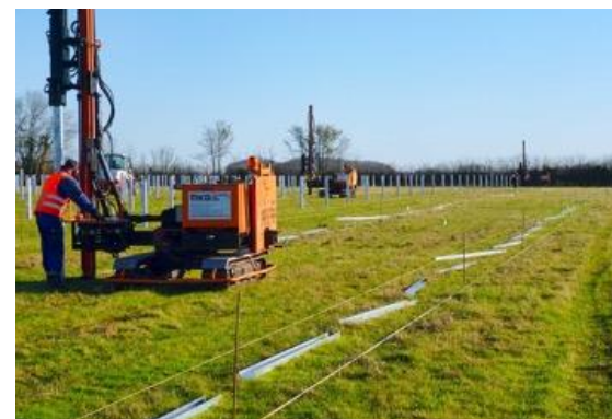
Photo 47 : Un exemple de batteuse de pieux (Source : mkg-goebel.de)
