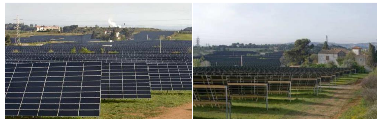
Photo 50 : Illustrations montrant le développement de la végétation sous les panneaux photovoltaïques
