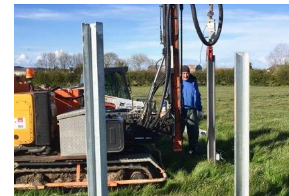
Photo 47 : Un exemple de batteuse de pieux (Source : mkg-goebel.de)
