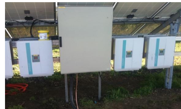
Photo 41 : Exemple d'onduleurs
