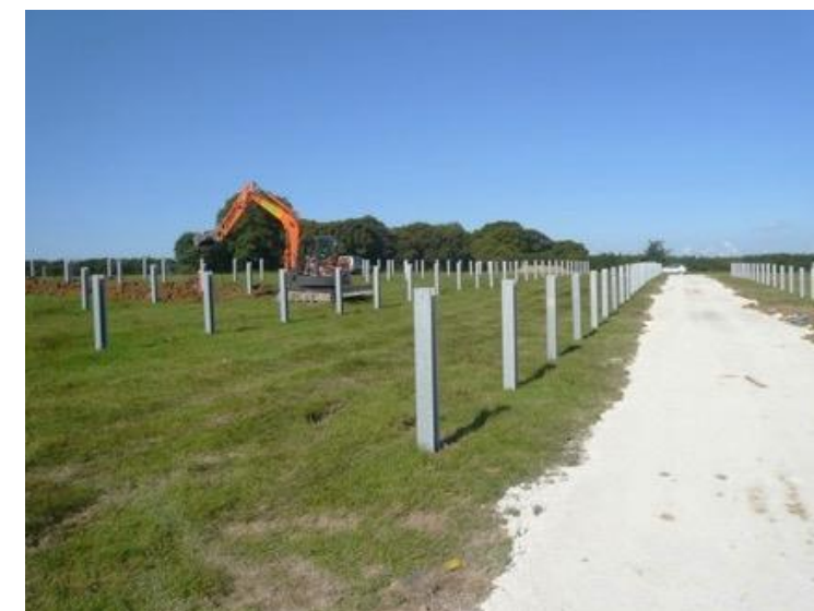
Photo 44 : Voie d'accès en matériaux concassés
